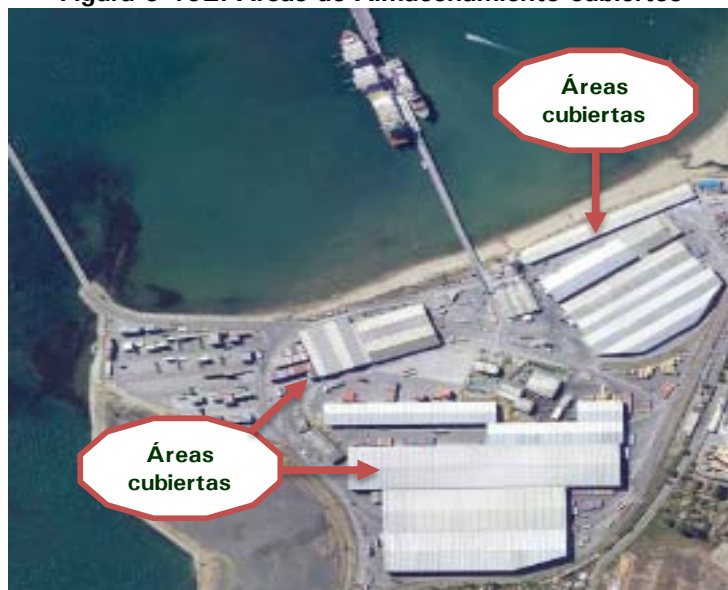
Figura 6-102. Áreas de Almacenamiento cubiertos
