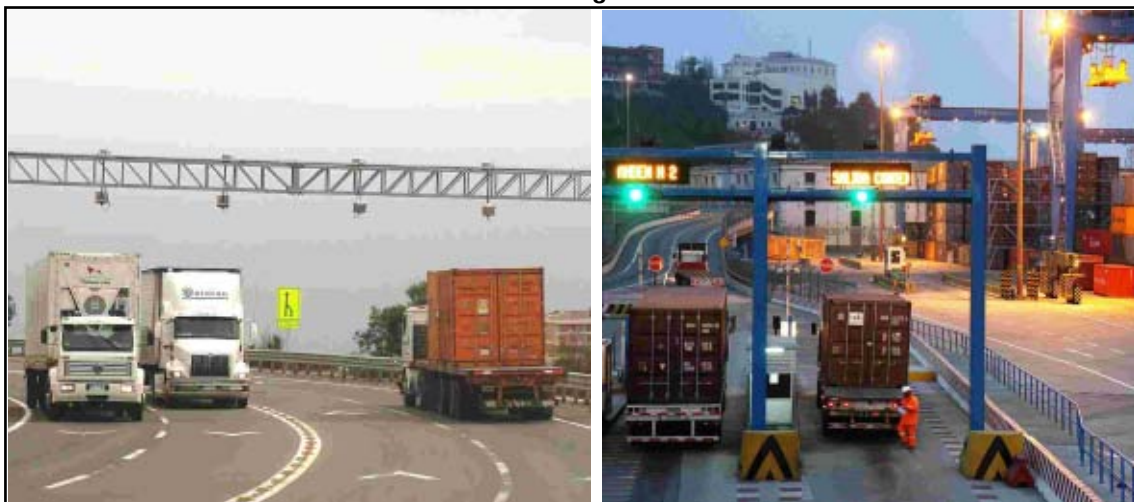
Figura 7-1. Portales y cámaras ubicadas en los accesos (Ruta La Pólvora) y Gates automáticos en el ingreso al Terminal
